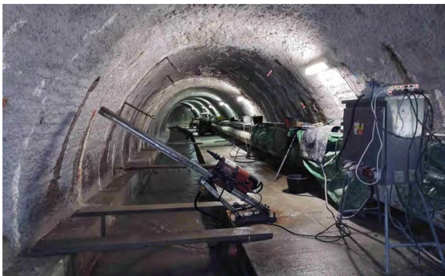
Injektáž ve štolě - vrtací souprava a vrty
